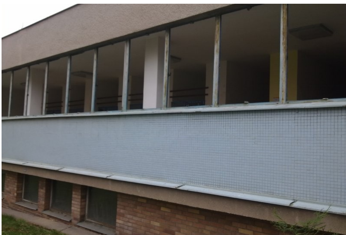
V červenci se rekonstruovala učebna 1.A , opravovala se kanalizace v pavilonu B.
